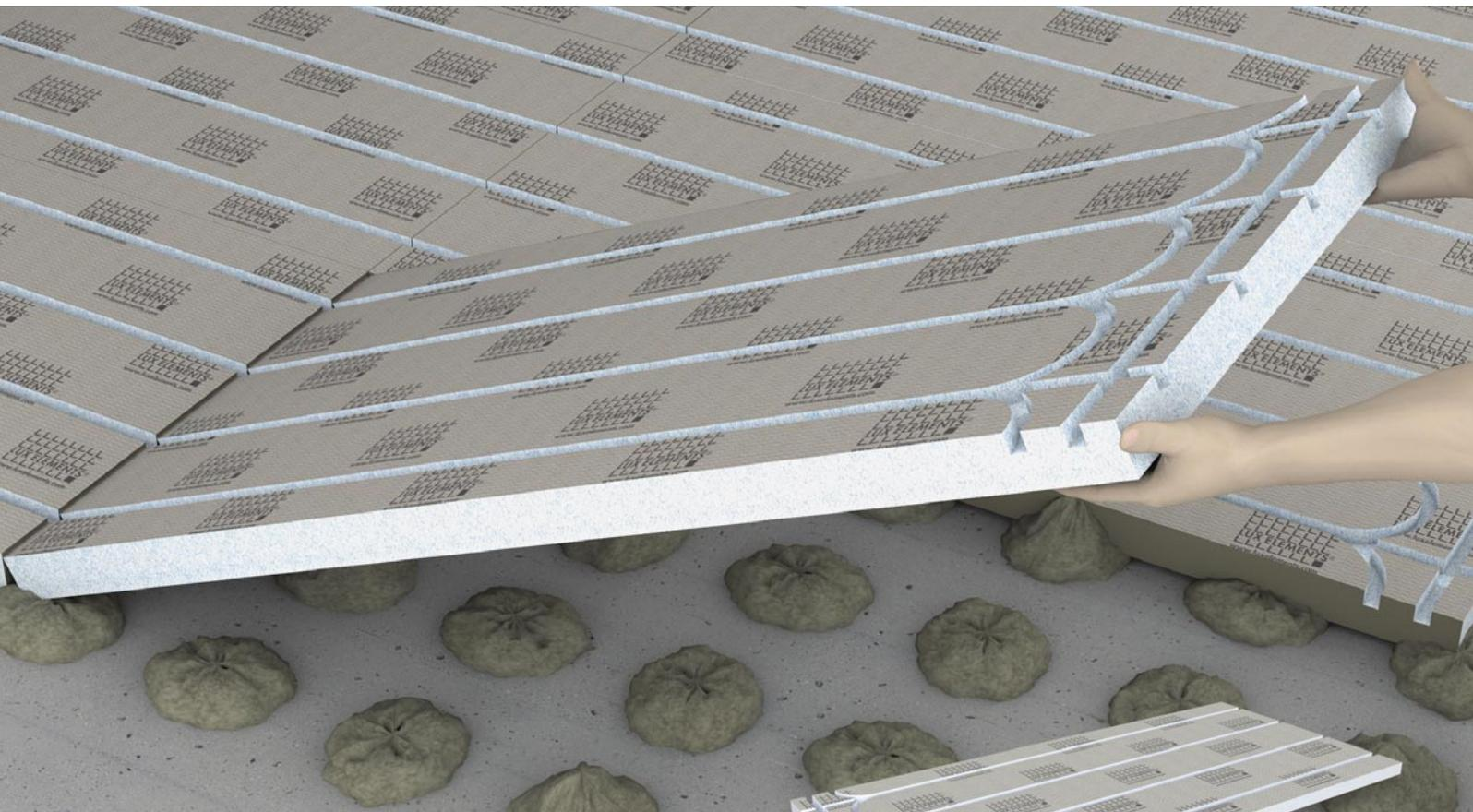
... ist sowohl für den Einsatz auf Holzböden als auch auf mineralischen Untergründen wie z.B. Beton oder Estrich geeignet. FLOOR-WH F 30 muss dabei immer vollflächig verklebt, FLOOR-WH F 50 kann auch auf Batzen gesetzt werden (Batzenabstand  $\leq 200$  mm). Bei Holzböden ist immer eine vollflächige Verklebung erforderlich!
