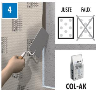
Enduire les bords des panneaux de construction ELEMENT-EL avec colle d'application COL-AK, de façons à colmater les vides entre panneaux et mur, aussi pour coller les différents éléments entre eux.
