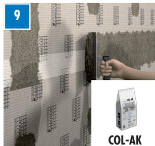
Appliquer la COL-AK à la spatule sur les raccords d'éléments armés ainsi que sur les têtes des chevilles à frapper.
