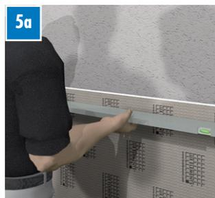
Nous recommandons une pose de niveau pour ELEMENT-EL. Si possible, apposer des traits de niveau avant le montage. Presser alors l'ELEMENT-EL contre le support avec une règle alu ou niveau à bulle afin de contrôler l'alignement horizontale ...
