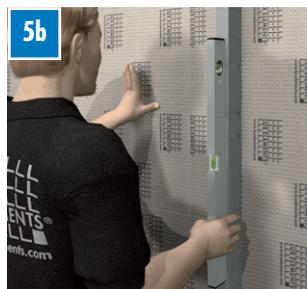
... mais aussi l'orientation verticale de chaque panneau de construction ELEMENT-EL ainsi que l'alignement des panneaux entre eux.
