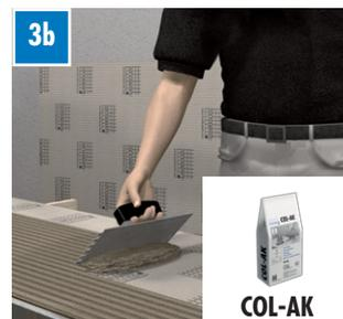
**REMARQUE:** En cas d'utilisation de ELEMENT-EL Baby 4, toujours appliquer la colle de montage COL-AK au moyen d'une spatule crantée. En fonction du support, cette technique est également possible pour des panneaux plus épais.
