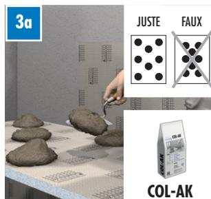
Selon le degré de planéité du support, appliquer la colle d'application COL-AK localement en posant des plots de colle (6 à 8 par m<sup>2</sup>) sur une face.
