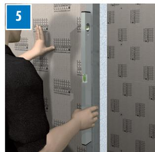
... ainsi que dans la glissière des profils MONT. Contrôler l'alignement vertical du panneau de construction ELEMENT-EL avec une règle à niveau.
