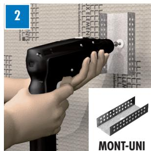
Fixer l'accessoire de montage MONT-UNI avec des fixations appropriées au mur ...
