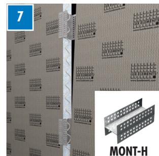
Poser l'ELEMENT-EL de raccord, l'aligner verticalement et horizontalement.
