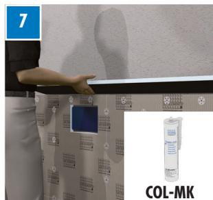
L'habillage peut être effectué à hauteur de pièce ou avec une tablette sur les installations. ELEMENT-EL 20 convient pour la couverture supérieure. Celui-ci est encollé avec de la colle COL-MK et fixé avec FIX-S 35 + une vis appropriée.
