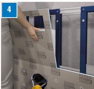
Pour le sens de montage (verticalement ou horizontalement), tenir compte des consignes du fabricant de la construction de bâtis-supports.
