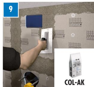
... les raccords armés entre les éléments ainsi que FIX-S 35 doivent être noyés avec la COL-AK.
