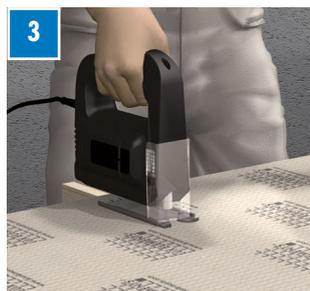
... les panneaux de construction ELEMENT-EL sont découpés de façon appropriée.
