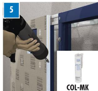
Les panneaux de construction ELEMENT-EL sont collés entre eux avec la colle COL-MK. Pour ce faire, appliquer la colle en continu sur le champ du panneau.
