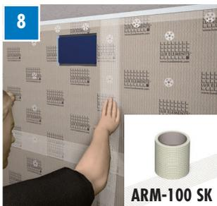
Tous les joints et raccords entre les éléments doivent être armés avec la bande d'armature en fibre de verre ARM-100 SK et ...
