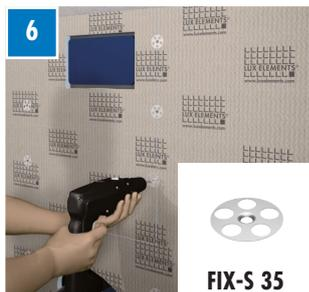
Le vissage doit être réalisé avec la rondelle FIX-S 35 + la vis appropriée. Les joints croisés ne sont pas autorisés. Concernant les écarts entre les joints, respecter les conseils du fabricant de la construction de bâtis-supports.
