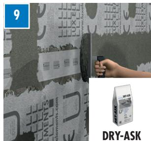
**9** Le collage de la bande d'étanchéité découpée s'effectue avec DRY-ASK. Pour terminer, enduire de DRY-ASK.
