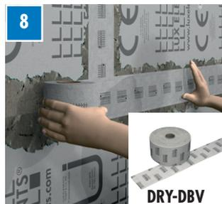
**8** Étanchéifier les têtes de cheville avec un petit morceau de bande d'étanchéité DRY-DBV et DRY-ASK. DRY-ASK s'applique au pinceau ou à la spatule.
