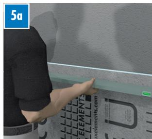
**5a** Nous recommandons une pose de niveau pour ELEMENT-VK. Si possible, apposer des traits de niveau avant le montage. Presser alors l'ELEMENT-VK contre le support avec une règle alu ou niveau à bulle afin de contrôler l'alignement horizontale ...
