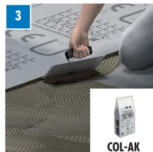
Mettre la colle d'application COL-AK en place avec une spatule dentée (en fonction du support, min. 6 mm) en couvrant uniformément.
