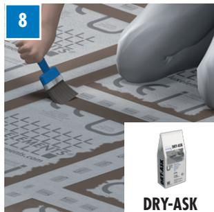
Dans un second temps, le raccord est recouvert avec DRY-ASK.
