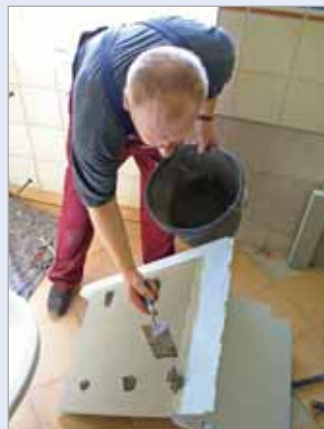
■ Dort, wo sich die Bohrlöcher befinden, wird auf der Rückseite der Wannerverkleidungen jeweils ein Batzen Ansetzkleber LUX ELEMENTS®-COL-AK aufgebracht.
