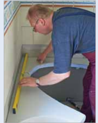
■ Der Einbau in Einzelschritten: Der Handwerker richtet die vorgefertigten Teile mit der Wasserwaage aus. Er prüft die Maßhaltigkeit und Paßgenauigkeit.
